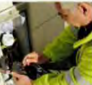
Un capteur IBM installé sur un feu de circulation pour collecter des données de trafic en temps réel.
