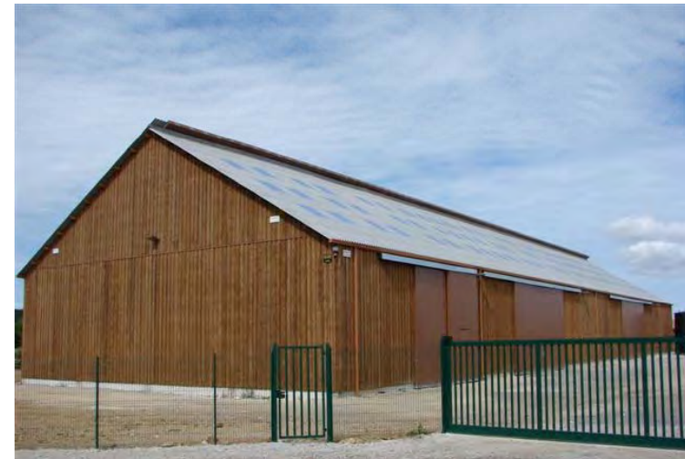
Hangar en bois, toit photovoltaïque, Essonne
