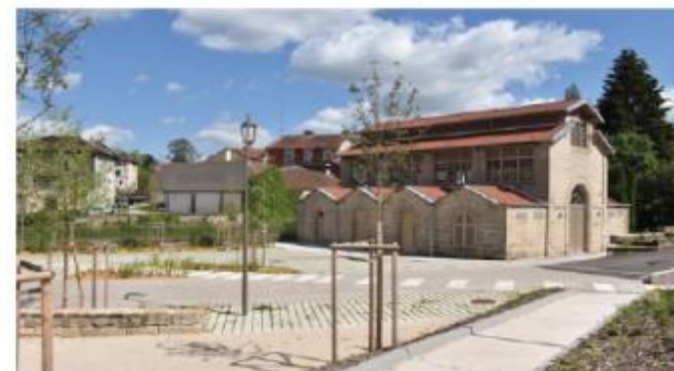
Photo après travaux
