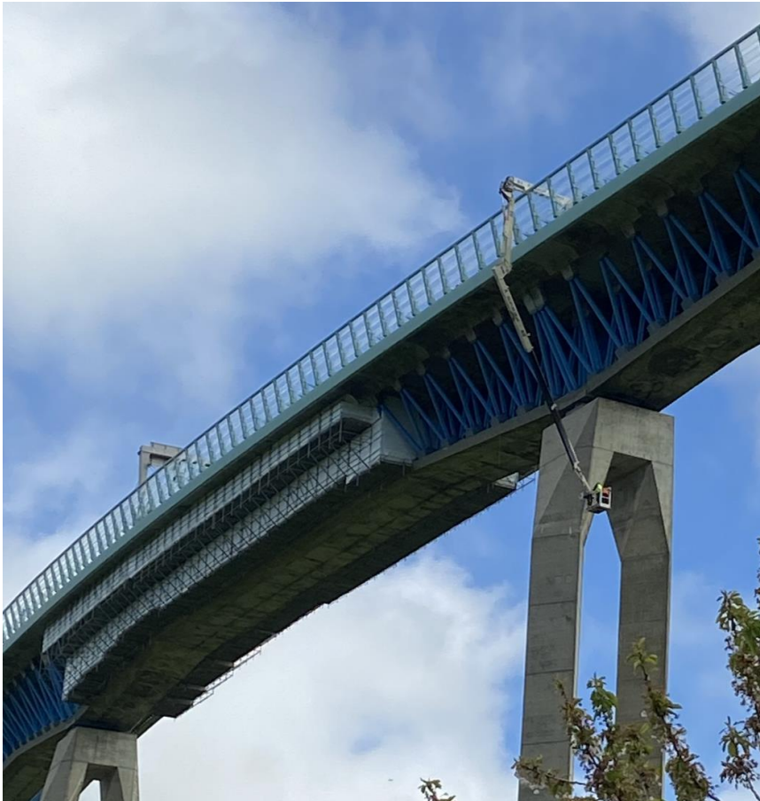
Entretien et inspection viaduc d'Echinghen ©JCSM
