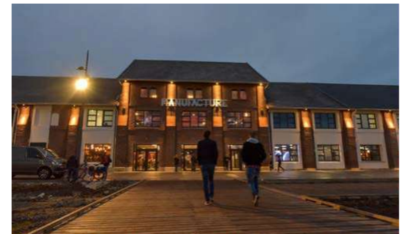
La Manufacture à Dieppe (Seine-Maritime)
