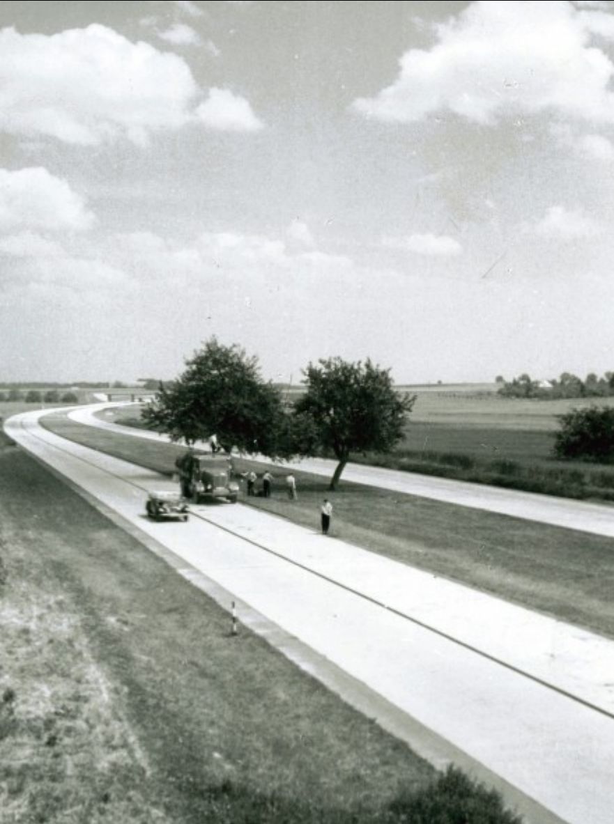
Reichsautobahn à Luwigsburg, finition sur la plate-bande centrale, 1937
