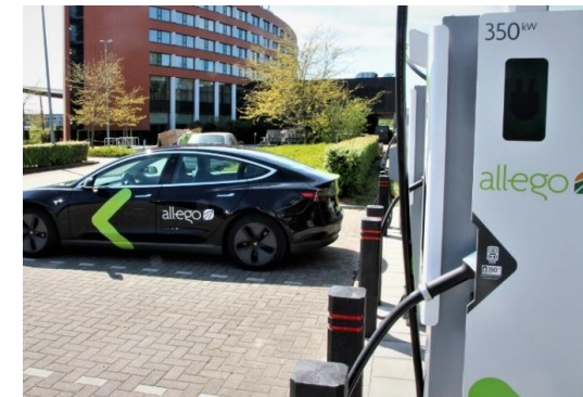
Borne de recharge électrique Allego Toulouse
