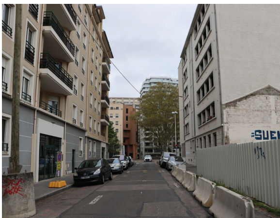
Tronçon entre rue Paul Bert et rue des Rancy
