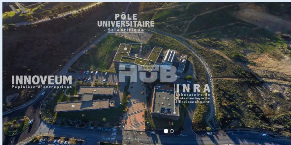
Plateforme technologique à Narbonne
