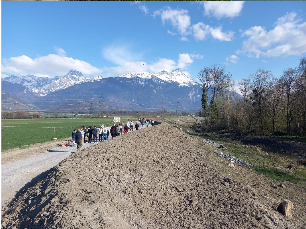
Visite du chantier de la mesure anticipée de Grandes Îles. A gauche l'ancienne digue, en mauvais état. A droite une nouvelle digue, plus éloignée du lit du fleuve pour lui redonner de l'espace. Crédits : Charlène Lepelletier
