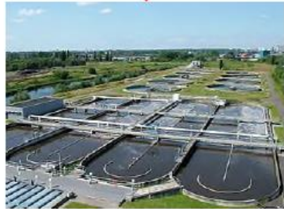
4 stations de traitement des eaux usées
