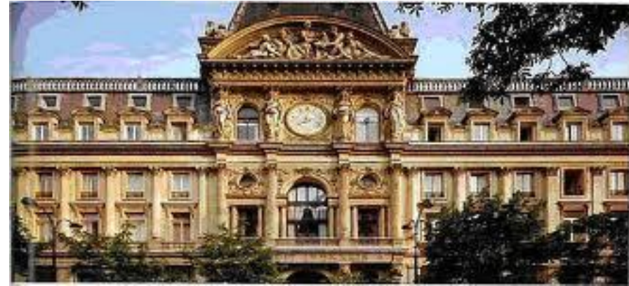
Boulevard des Italiens, Banques (Crédit Lyonnais)
